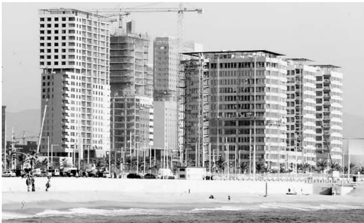
Pisos en construcció al litoral de Barcelona, a la zona de Diagonal Mar. / ANDREU PUIG.
